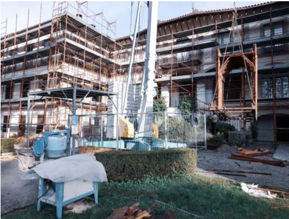
Baustelle Teil 2 – die Villa Garovaglio
