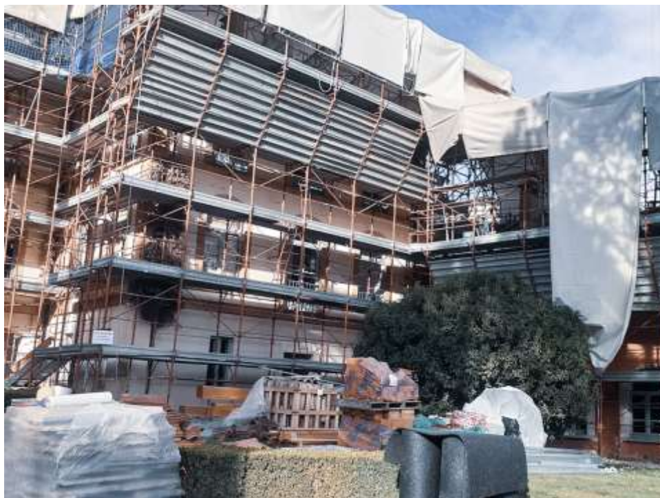
Auch hier wird das Dach strukturell ertüchtigt
