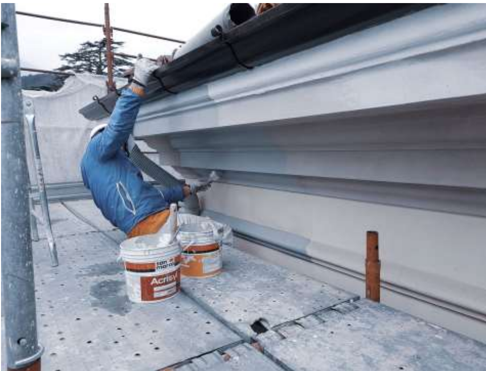
Feinmalerarbeiten an der Fassade
