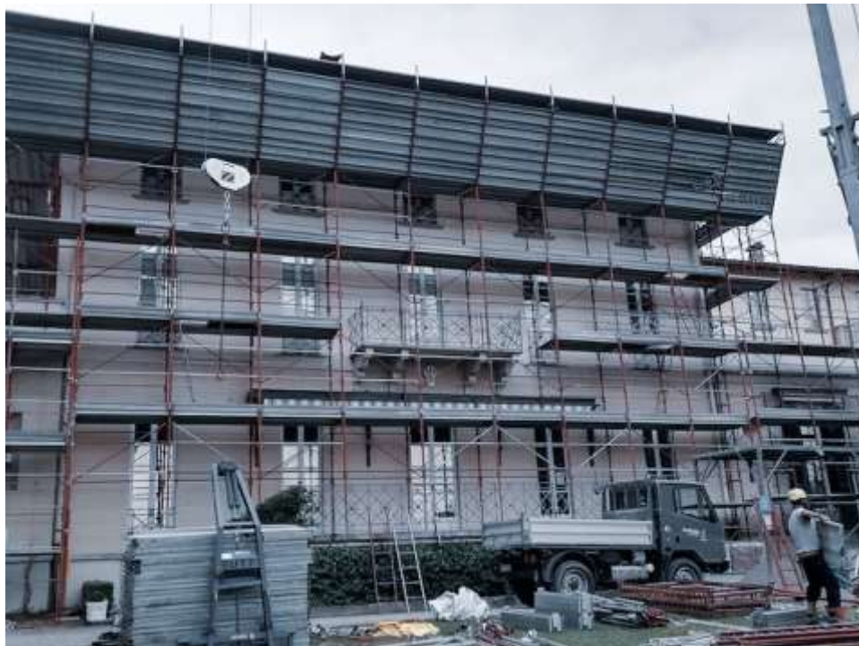
... Errichtung des Gerüsts
