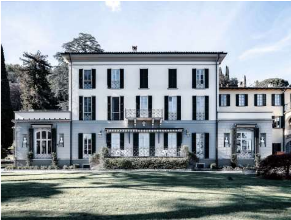
Die Fassade in neuem Glanz
