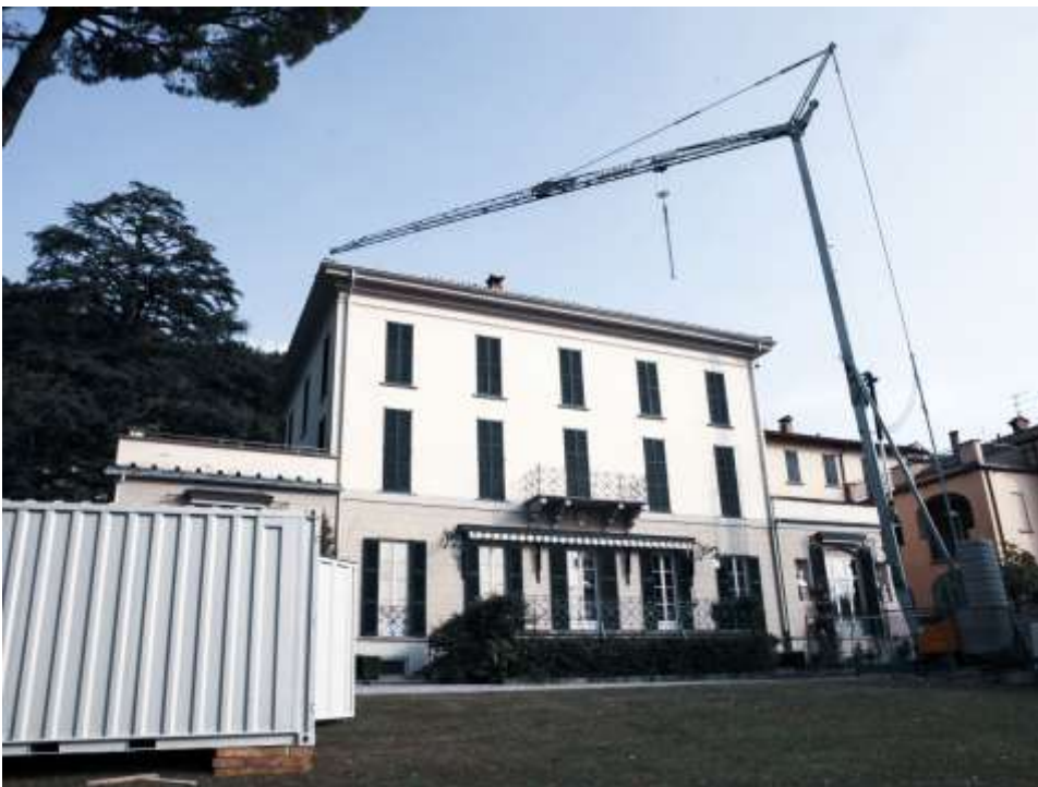
Der Kran steht
