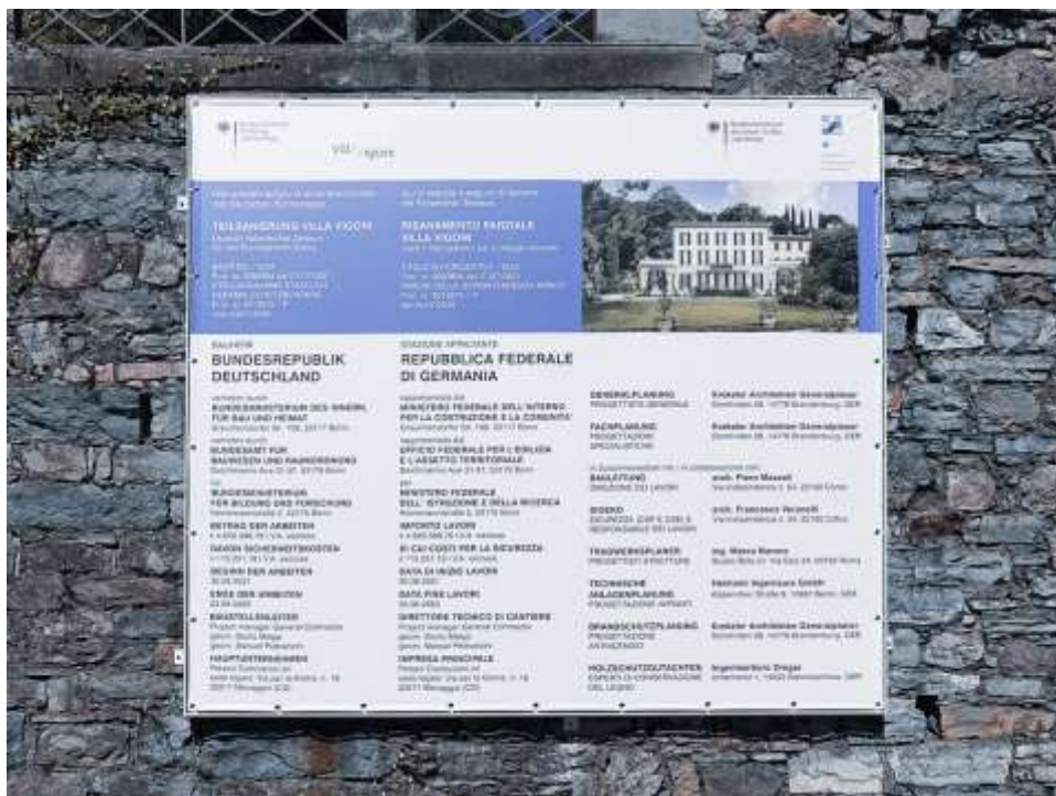
Das große Baustellenschild
