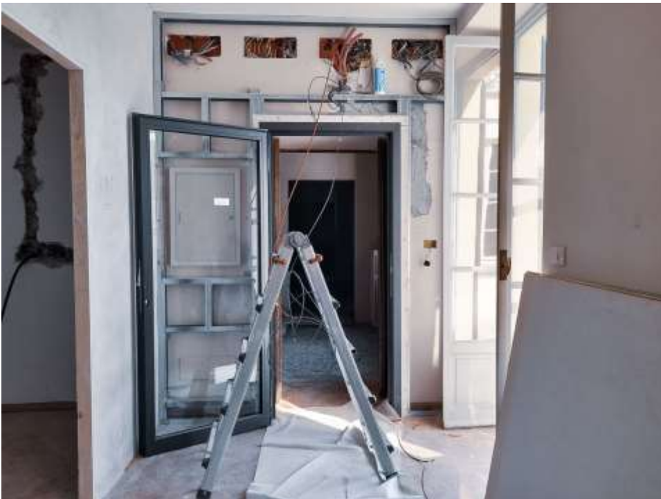
Einbau der Brandschutztüren
