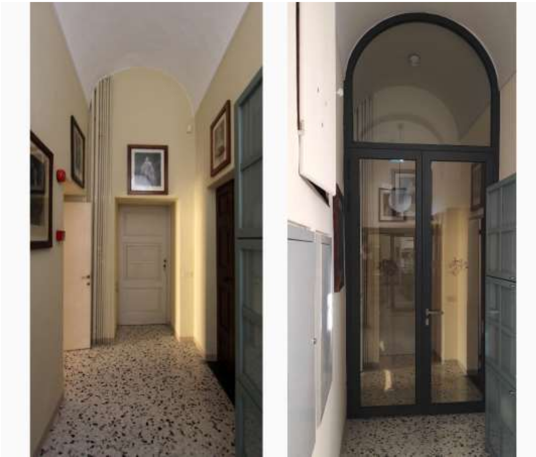
Ohne (vorher) und mit (nachher) Brandschutztür
